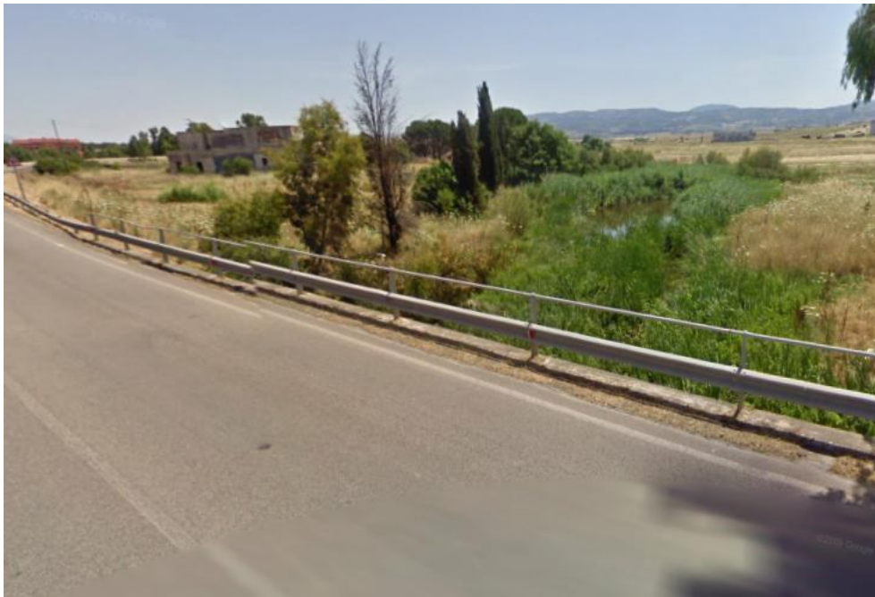
Figura 7 - Ponte della SP63 sul Rio Rizzolu.
