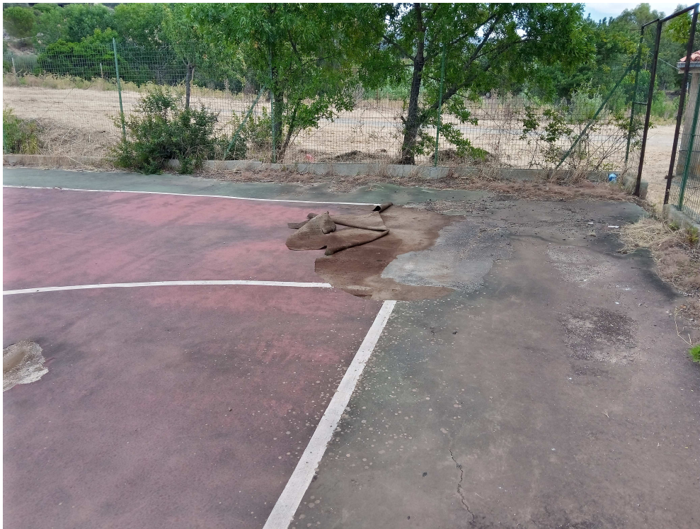
Figura 3 particolare delle zone del campo sollevate
