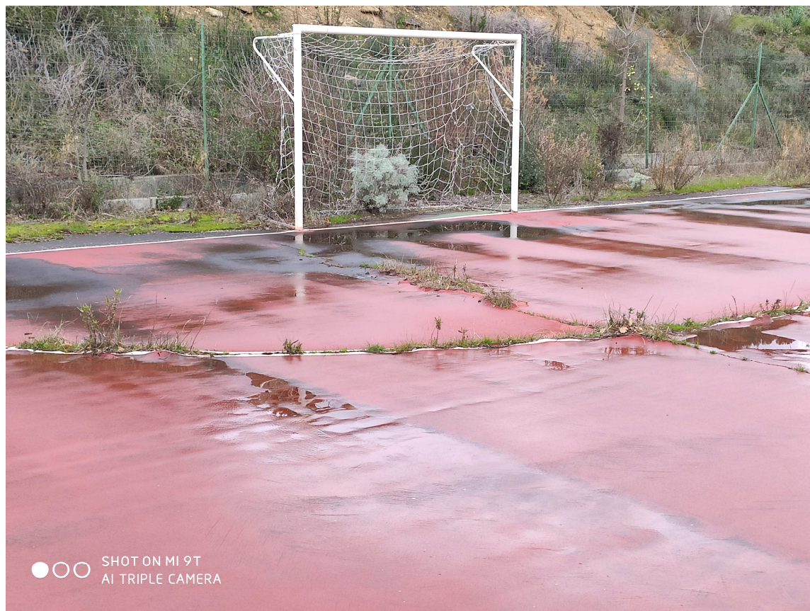
Figura 2 particolare delle zone del campo sollevate e disconnesse
